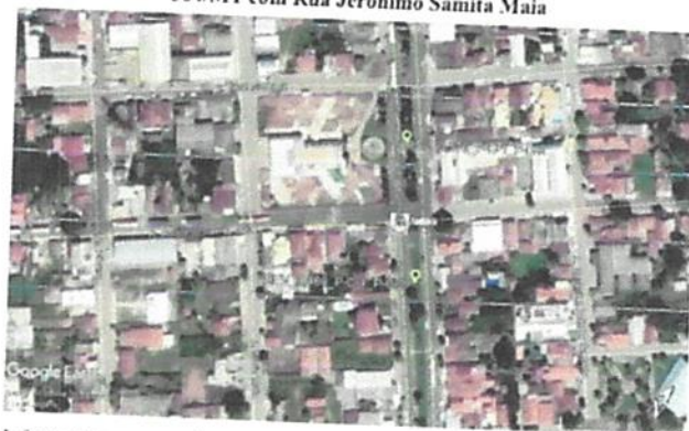
Figura 01 - Equipamentos Redutores Eletrônicos de Velocidade nas aproximações da BR-364/MT com Rua Jerônimo Samita Maia
